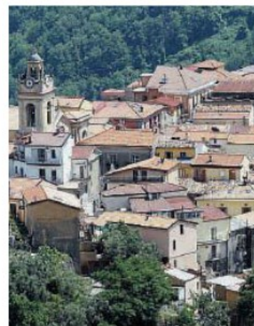
Problemi idrici in zona sud
