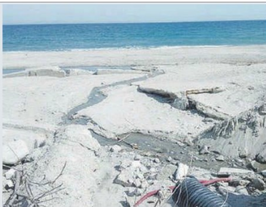
Il collettore. Lo scarico di acque mefitiche sulla spiaggia di Caulonia
