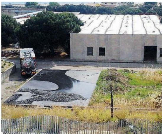
Contestato. Il vecchio depuratore che sorge nel rione Ravagnese
