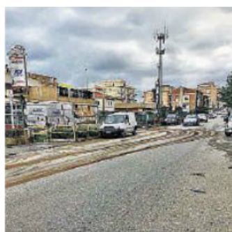
I lavori in via Nazionale. Continua l'intervento di bonifica dell'area
