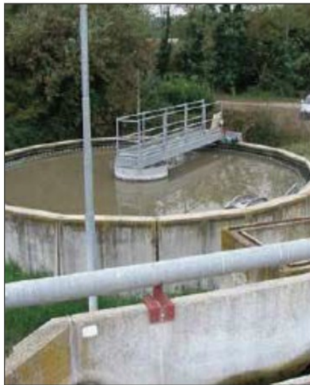
Un impianto di depurazione delle acque
