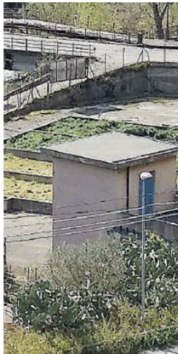
Sotto osservazione. L'impianto di depurazione di Mammola
