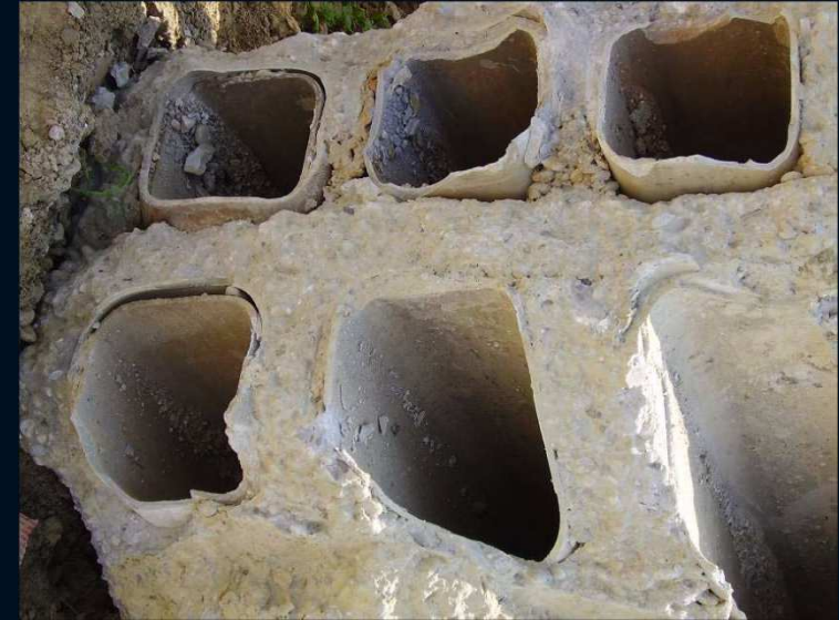
Tubi inseriti in cemento
