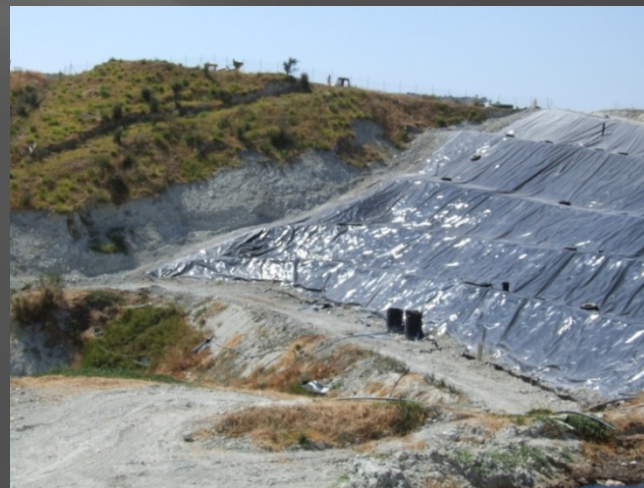
Isolamento con geomembrana
