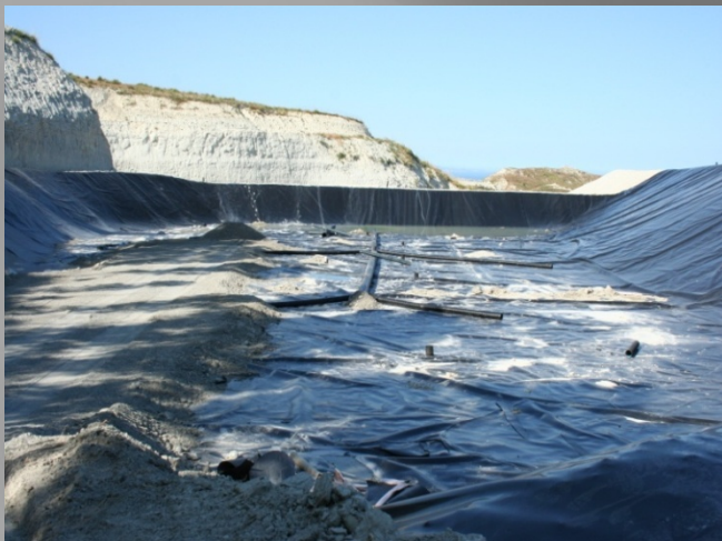
Impermeabilizzazione della vasca con geomembrana in HDPE
