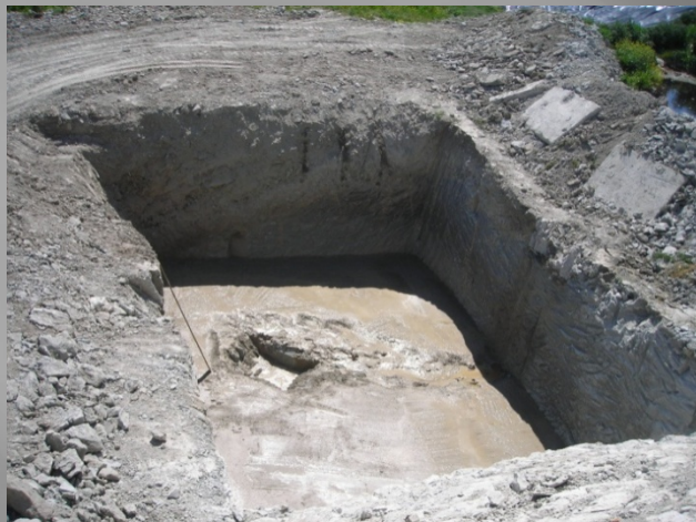
Fosso costruzione vasca raccolta percolato
