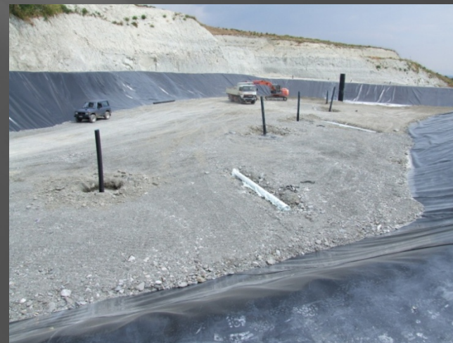
Ricoprimento del fondo della vasca
