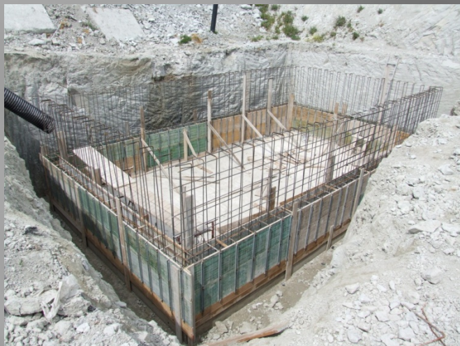
Avanzamento lavori di costruzione vasca raccolta percolato
