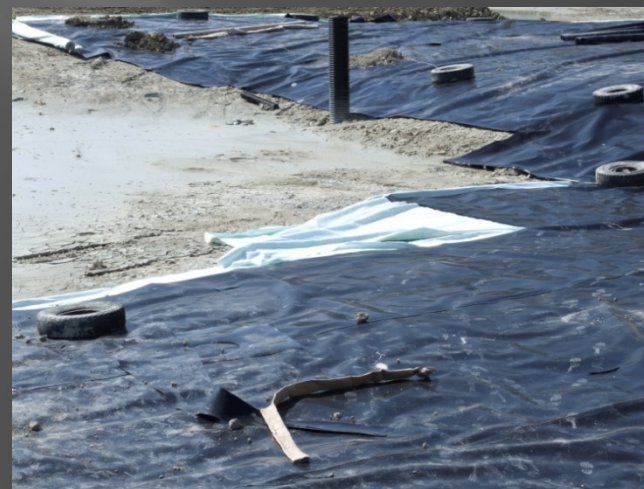
Realizzazione di un nuovo lotto per l'abbanco dei rifiuti
