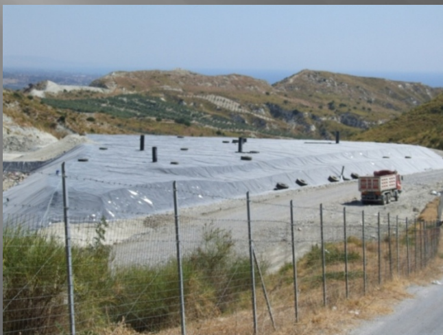
Isolamento corpo discarica esaurito
