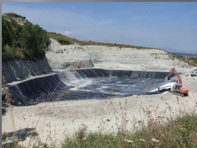
Rete di canali per la raccolta del percolato
