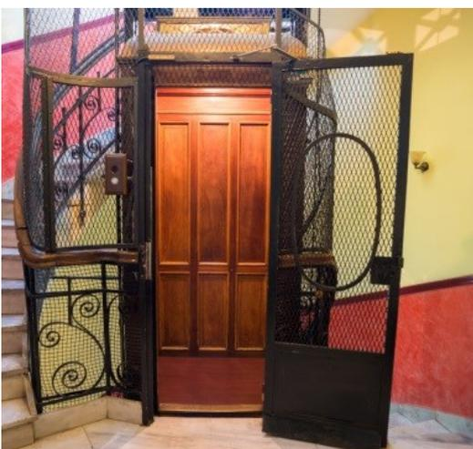
Mentre per i vecchi ascensori, il potenziale di risparmio energetico arriva al 50-60%, ed è ottenibile sostituendo le vecchie lampade con lampade a LED, sostituendo i motori con modelli ad alta efficienza e attivando le funzioni "Risparmio energia", che spengono i componenti non essenziali quando l'ascensore non è in uso.
