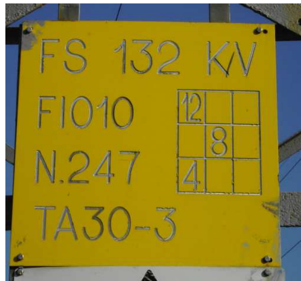
Esempi di targhe con la dicitura “FS” presenti sui sostegni delle linee di R.F.I. S.p.A. che riportano la tensione nominale, la disposizione delle fasi, il tipo di testa ed il numero progressivo del sostegno.
