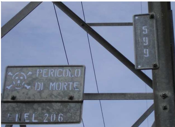
Esempio di targa con la dicitura “ENEL”, presente sui sostegni delle linee di Terna S.p.A., che riporta il numero del sostegno insieme all’altra targa che riporta il numero della linea (linea n. 599, sost. n. 206).
