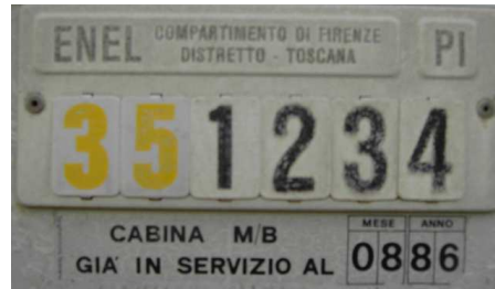
Esempio di targa, presente sulle cabine secondarie di trasformazione (MT/BT) da cui partono le linee di media tensione di ENEL S.p.A.
