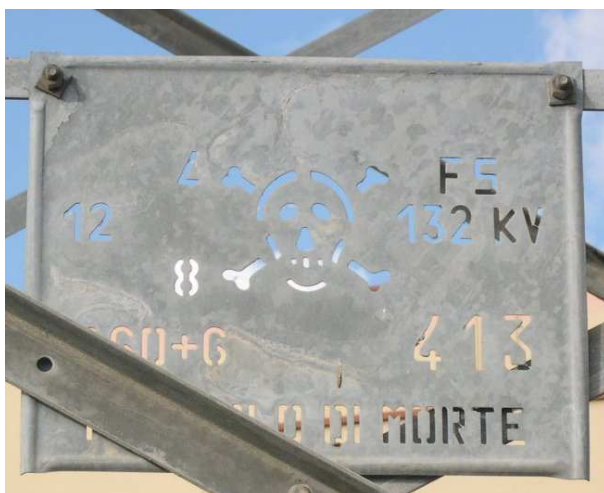
Esempi di targhe con la dicitura “FS” presenti sui sostegni delle linee di R.F.I. S.p.A. che riportano la tensione nominale, la disposizione delle fasi, il tipo di testa ed il numero progressivo del sostegno.
