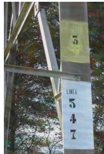
Altro esempio per le linee di Terna S.p.A. di numero della linea - su sfondo bianco - e numero del sostegno - su sfondo giallo - (linea n. 547, sost. n. 3).
