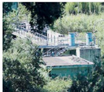
Incompiuta Il depuratore consortile di Francavilla mai entrato in funzione
