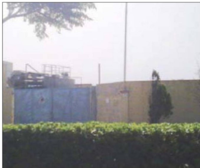
Il depuratore di Cirò Marina
