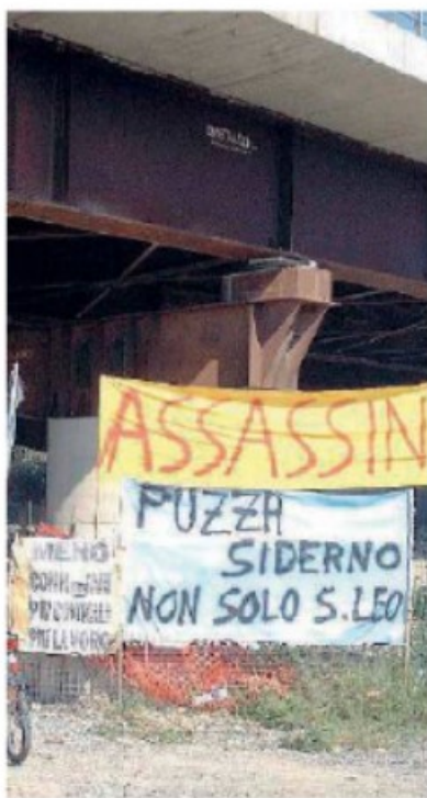
Impianto Tmb Uno dei punti critici del ciclo dei rifiuti della Locride
