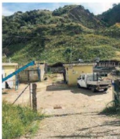
L'impianto Il dissequestro subordinato all'adeguamento del depuratore
