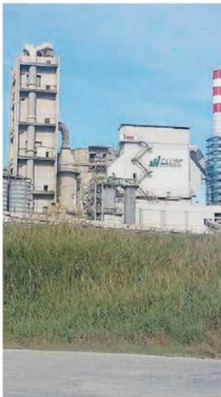
Industria L'impianto di Marcellinara
