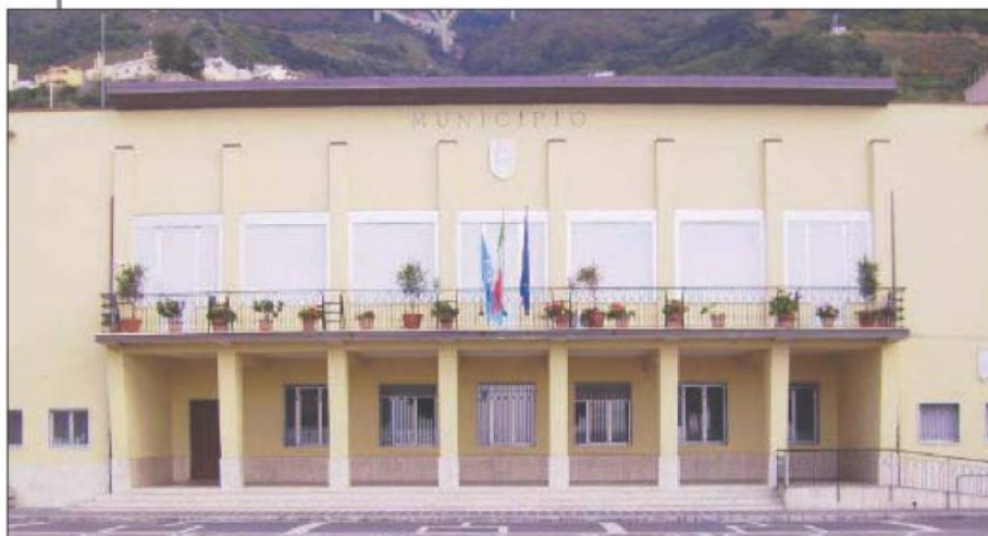
Il palazzo municipale di Bagnara Calabria
