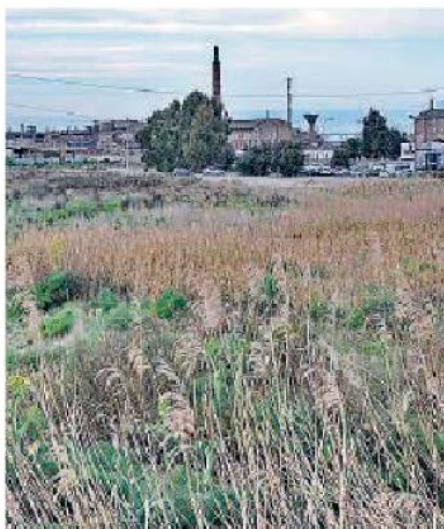
L'area Il sito davanti all'ex Montedison
