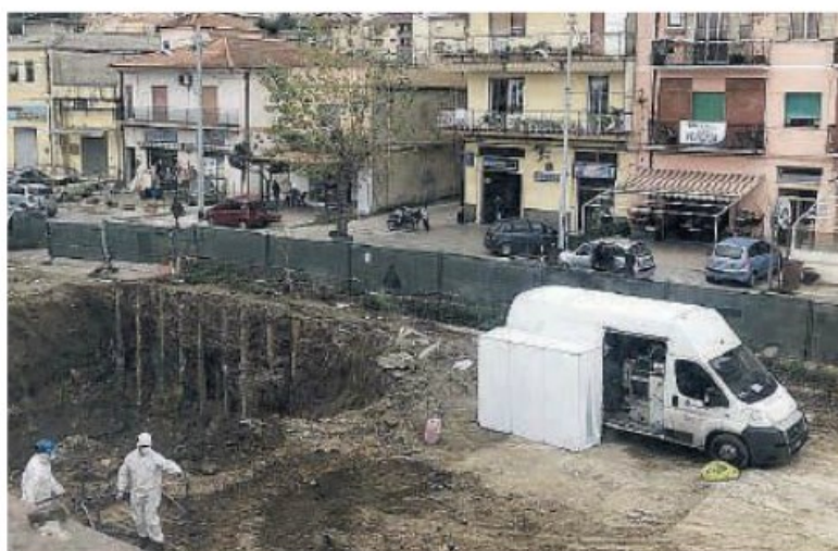
L'impianto Eni. L'attività di rimozione dell'amianto eseguita nei giorni scorsi
