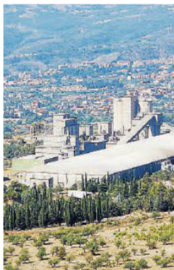
Castrovillari. Il cementificio
