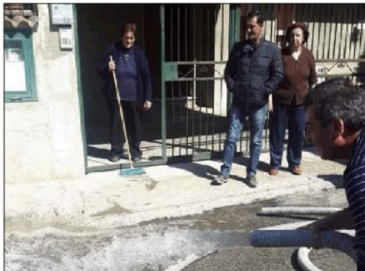
I lavori sulla rete idrica interna della frazione Marina
