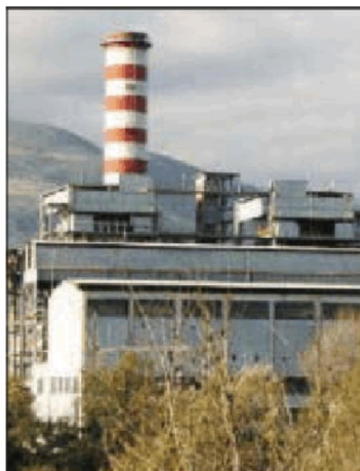
La centrale del Mercure
