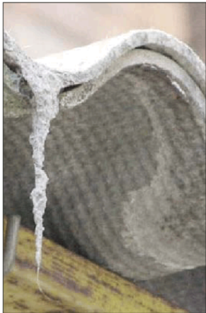
Concordate procedure per il controllo dell'amianto
