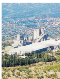
Il cementificio. L'area dovrebbe ospitare l'ecodistretto dei rifiuti
