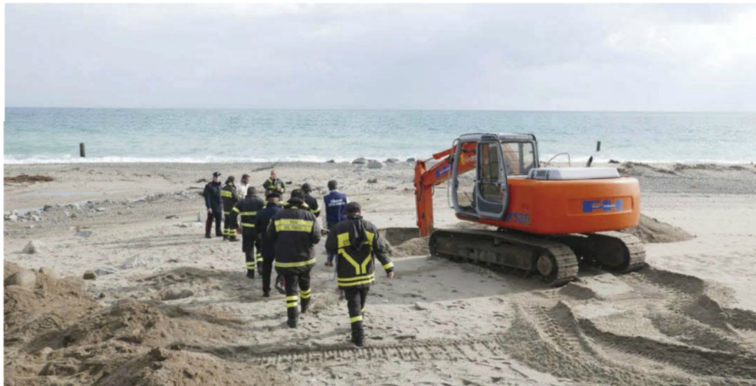
Le ricerche. Escavatore dei vigili del fuoco alle prese con approfondite ricerche sulle spiagge di Montauro dopo l'allarme lanciato sull'inquinamento radioattivo
