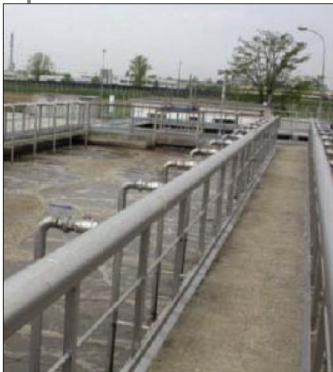
Un impianto di depurazione
