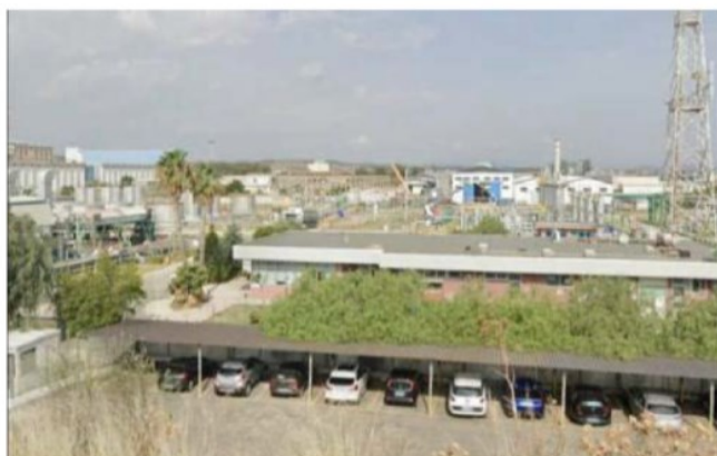
La centrale Area a un passo dalla svolta ambientale
