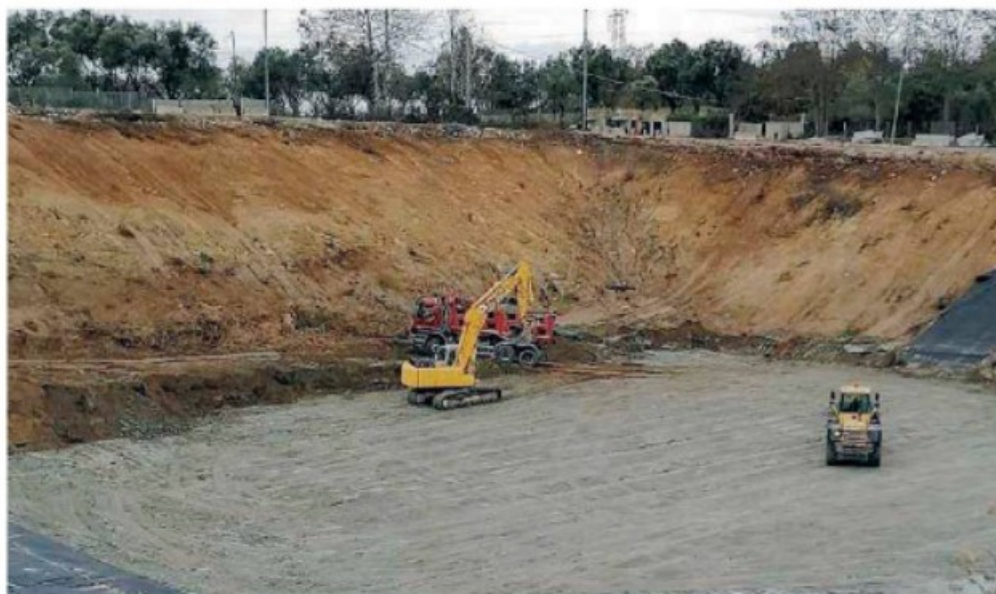
Discarica “La Zingara” | I lavori per la riapertura del sito di Melicuccà
