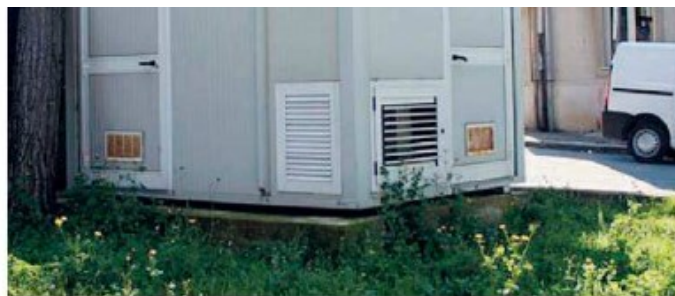
Villa Una centralina per il monitoraggio dell'inquinamento ambientale
