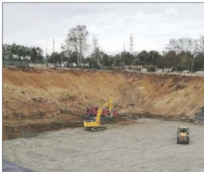
Lavori alla discarica di contrada La Zingara a Melicuccà
