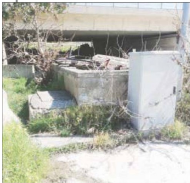
Il depuratore di Lazzaro
