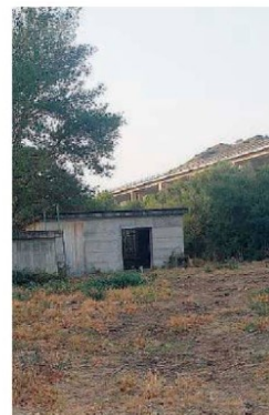
Rotta La stazione di sollevamento
