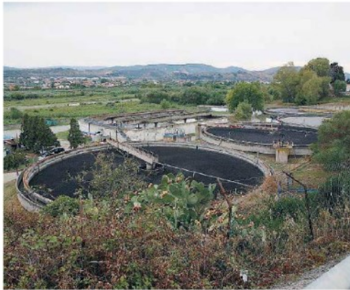
Le vasche Il depuratore in località Verghello
