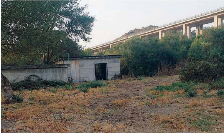
Abbandonata La stazione di sollevamento oggetto dell'ordinanza del sindaco Abramo
