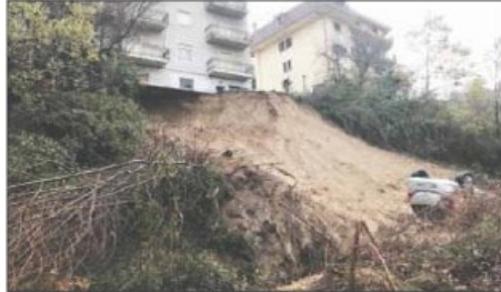
La frana a Celico e il torrente Saraceno ingrossato
