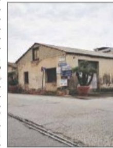
La struttura col tetto in eternit
