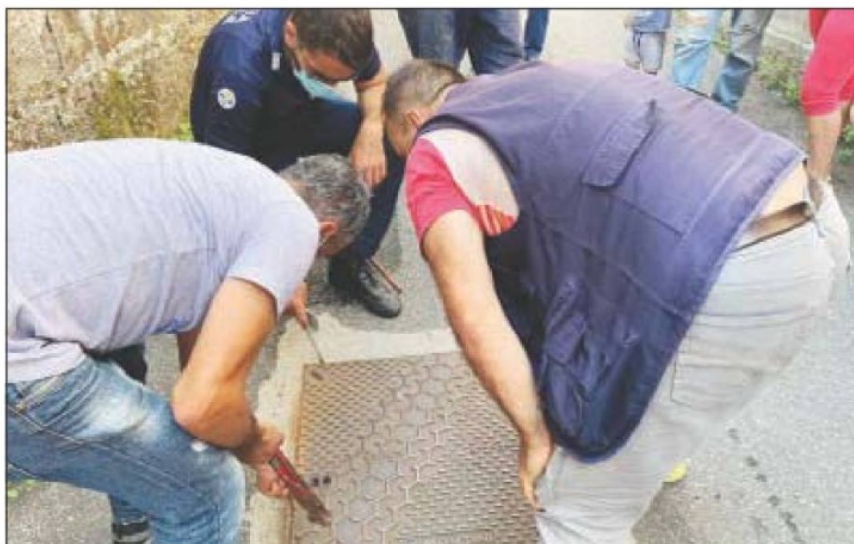
Gli accertamenti effettuati alle condutture
