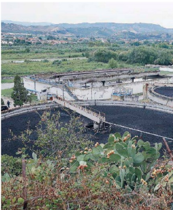
Le vasche L'impianto di depurazione in località Verghello
