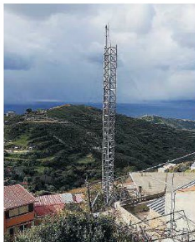
Contrada Lacco Il grande impianto che incombe sulle case
