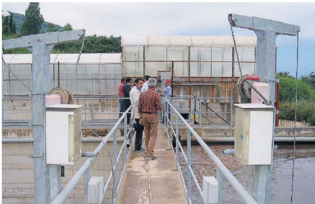
Nodi da sciogliere L'impianto di depurazione di località Argani a Tropea come ogni anno in emergenza a causa dei fanghi da smaltire e del personale in stato di agitazione
