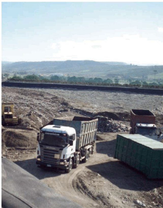
Camion che conferiscono rifiuti nella discarica di Lamezia Terme
