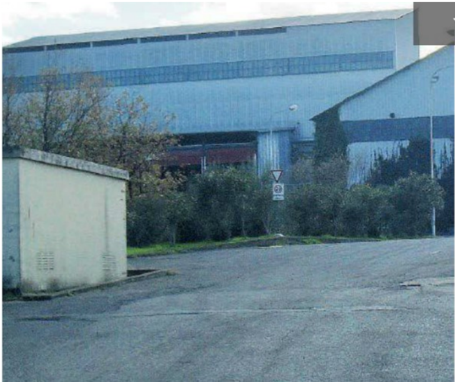
L'impianto di selezione dei rifiuti di Bucita Diminuisce la preoccupazione
