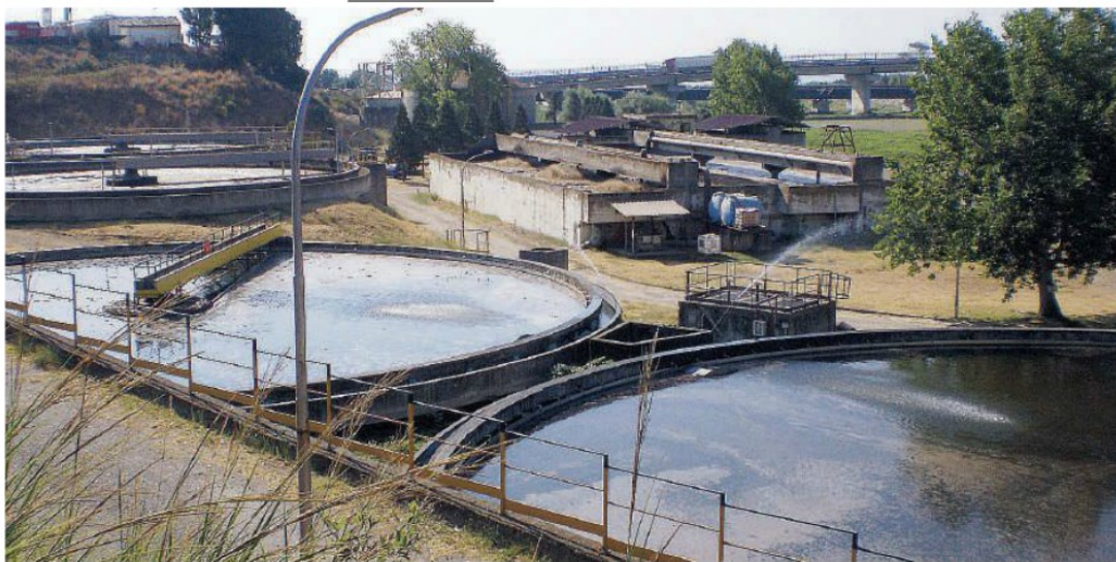
Gli accertamenti. L'impianto di depurazione di località Verghello mercoledì scorso è stato al centro delle verifiche della Guardia costiera
