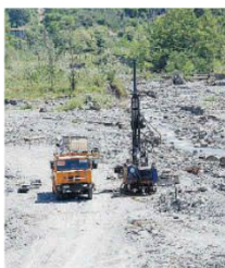
Analisi approfondite. I carotaggi svolti nell'alveo del torrente
