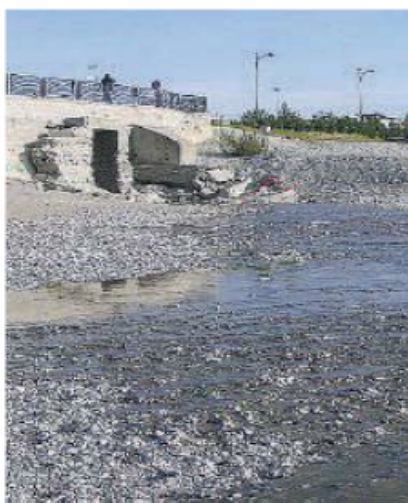
Scarico a mare. Fuoriuscita dal fosso Barbaruzza
