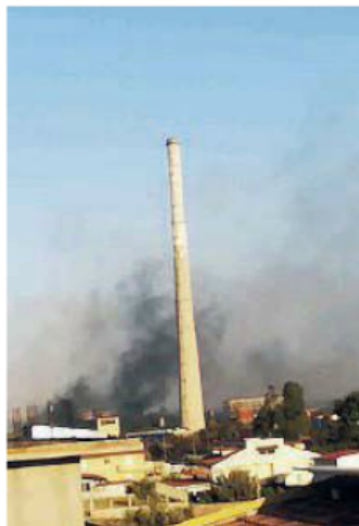
Ex Liquichimica. L'incendio nella fabbrica abbandonata
