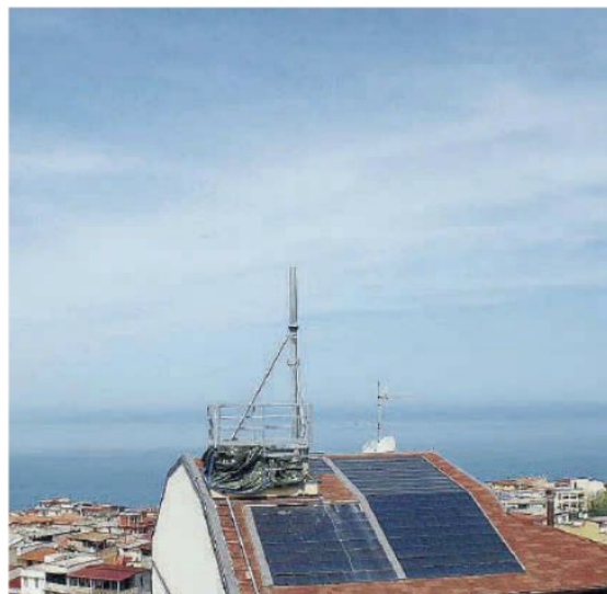
Palmi. L'impianto di telefonia mobile sul tetto dello stabile di via Buozzi
