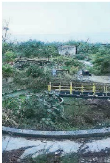
L'impianto L'area da riqualificare
