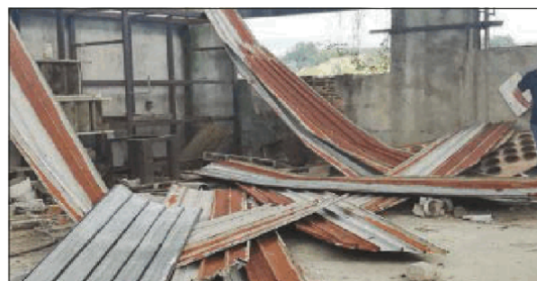
Lastre di metallo ed eterniti all'interno dell'ex Fornace di località tranquilla
