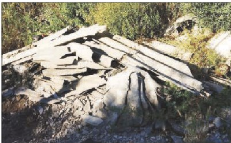
Un cumulo di lastre d'amianto rotte
