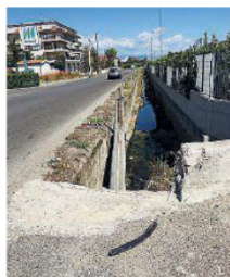
Il canale. Ha giocato un ruolo importante dell'alluvione del 2015
